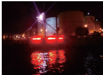
부두 인식등 설치
