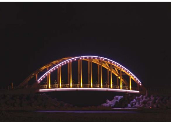
방파제 LED 인식등 설치 전경
